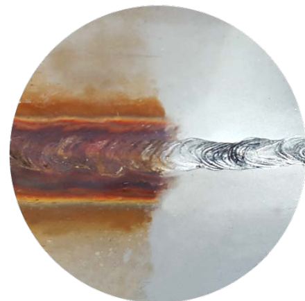
Svetssöm före/efter rengöring
