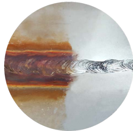
Svetssöm före/efter rengöring
